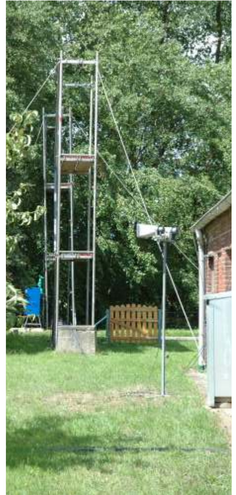
Kabelbrücke am Haus
